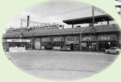
高架化された津島駅 昭和45年(1970年)撮影
