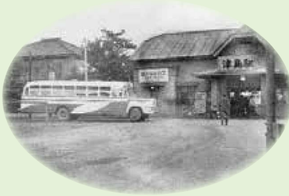
木造平屋建の津島駅 昭和30年(1955年)撮影
