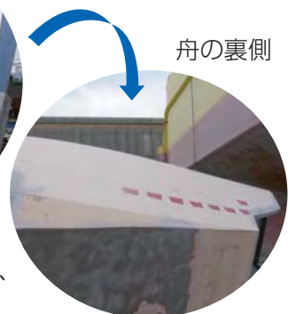
サンドブラストで塗装をはがし、腐食の除去などを行う。
