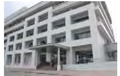
▲耐震工事が完了した市役所本庁舎
