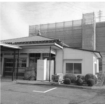
▲工事が進む斎場
