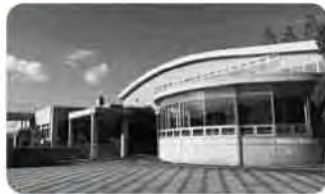
▲津島総合プール
