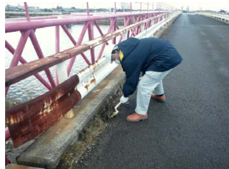
写真-3.4 道路パトロール状況②
