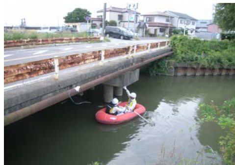
写真-3.2 専門業者による点検状況
