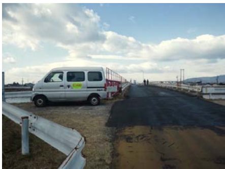
写真-3.3 道路パトロール状況①
