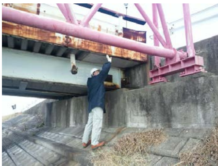
写真-3.1 職員による点検状況
